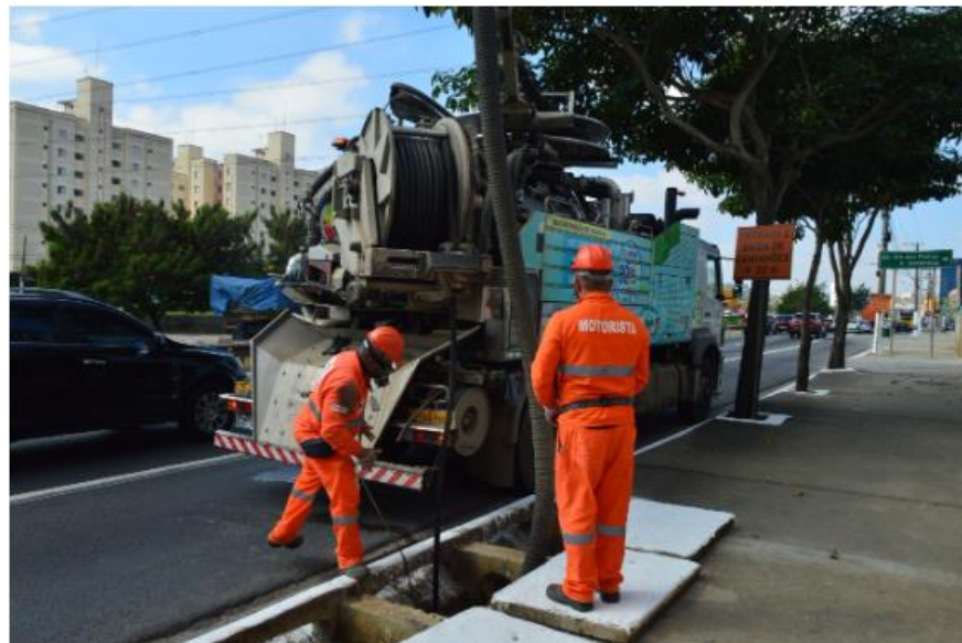
Legenda: Exemplo de Serviço de Microdrenagem.
