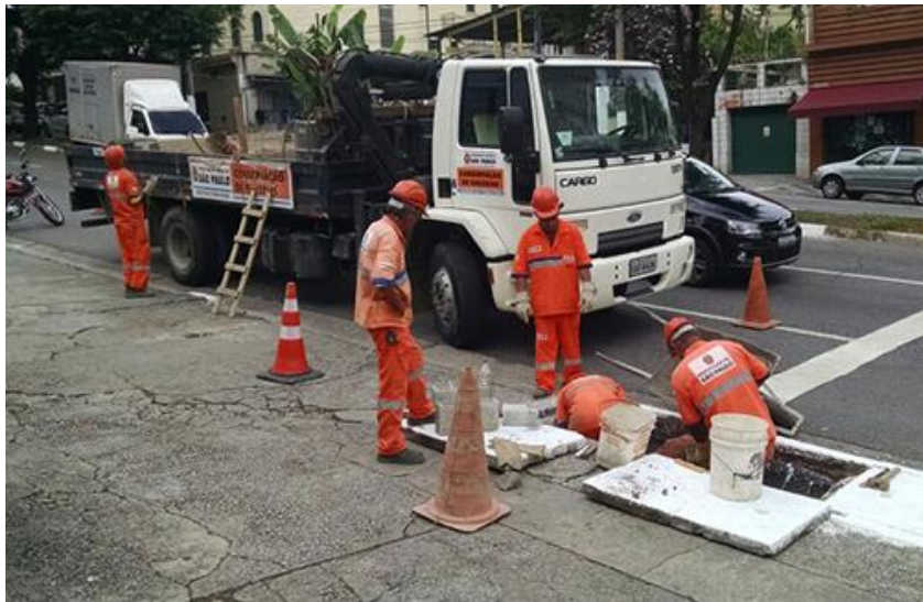
Legenda: Exemplo de Serviço de Drenagem
